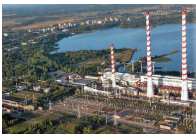
1.9 pav. Lietuvos elektrinė Elektrėnuose – didžiausia mūsų šalies šiluminė elektrinė. Ji degina dujas ir biokurą, kuriuose slypi kadaise augalų sugerta saulės energija.
