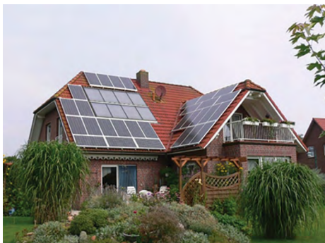
1.10 pav. Energija apsirūpinantis namas. Jo stogas padengtas saulės baterijų plokštėmis, kurios paverčia spindulių energiją elektros energija.
